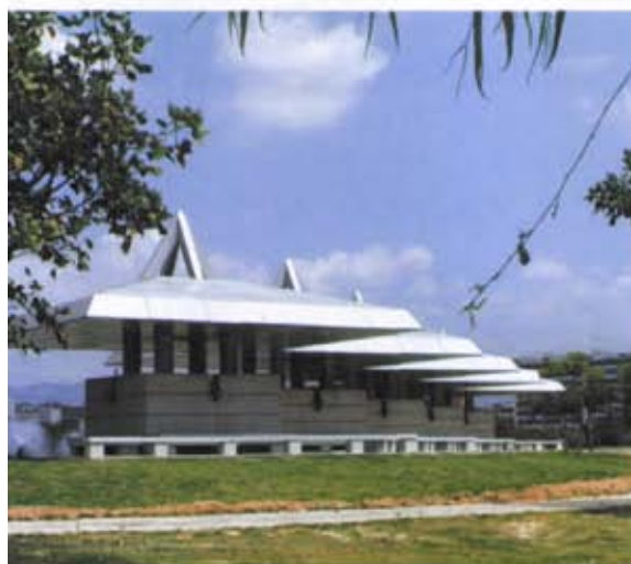
图13 厦门杏林日东公园游廊
